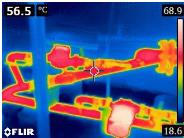
Тепловтрата через неізольовані ділянки трубопроводів в котельні
