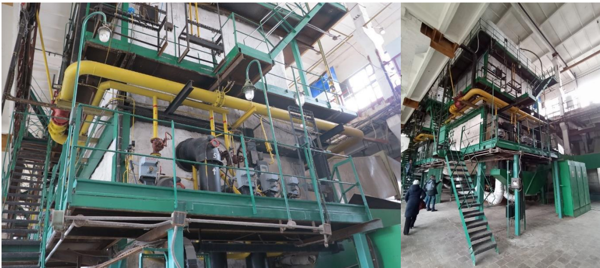
Рисунок 1.2 - Котли ПТВМ 30М
