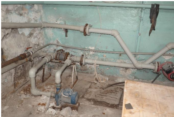
Рисунок 1.6 – Система опалення основного корпусу
