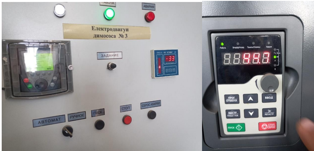
Рисунок 1.6 – Частотно-регульований привід димососів та вентиляторів
