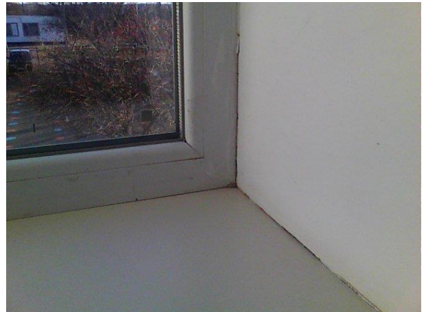
Тепловтрати через теплопровідні включення навколо вікон
