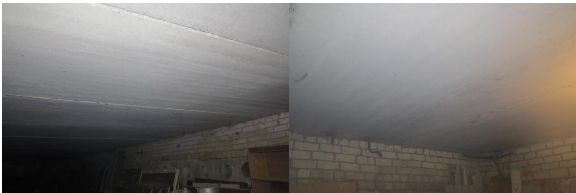
Рисунок 1.7 – Плита перекриття неопалювального підвалу
