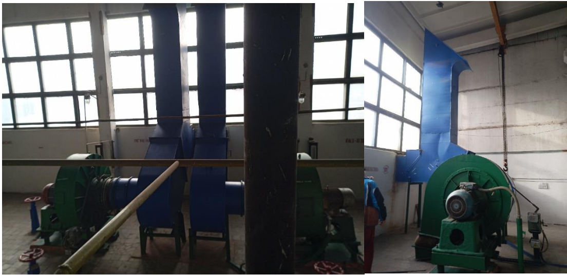
Рисунок 1.5 – Вентилятори ВДН-11,2
