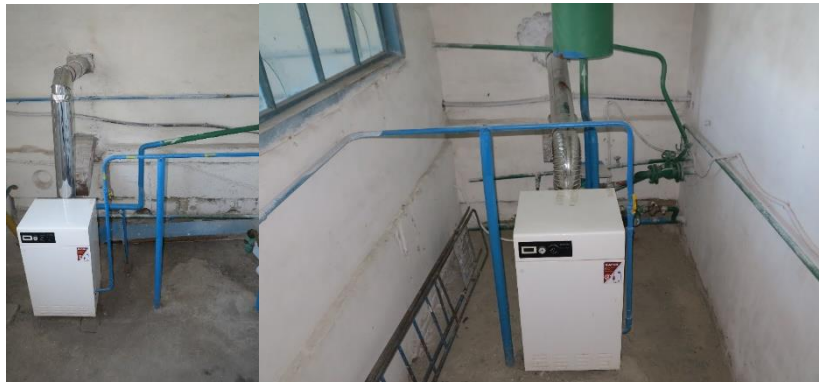
Рисунок 1.8 – Джерело теплової енергії (котли АТОН)
