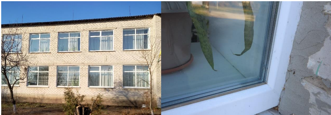
Рисунок 1.4 – Віконні конструкції будівлі
