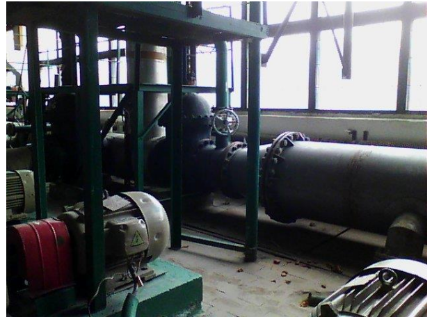
Втрати теплової енергії з неізольованих ділянок трубопроводів
