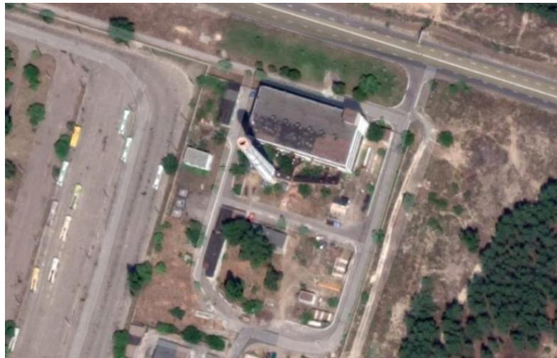
Рисунок 1.1 – Вид зверху котельні 83-го мікрорайону
